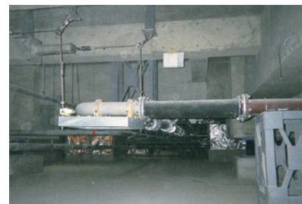
複数配管並列設置例(横吊りタイプ)
